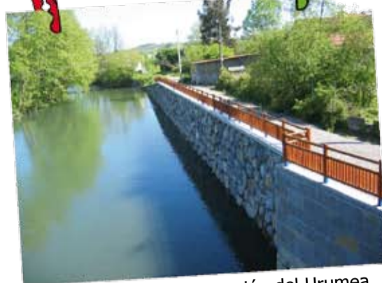
Canalización y regeneración del Urumea
